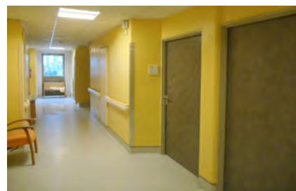
Circulation après rénovation
