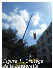
Figure 1 : Grutage de la passerelle
