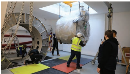
TRAVAUX D'INSTALLATION DU NOUVEL ACCÉLÉRATEUR DE PARTICULES AVEC IRM EMBARQUÉE EN RADIOTHÉRAPIE
