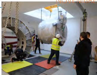
Installation du nouvel accélérateur de particules avec IRM embarquée en radiothérapie (Henri-Mondor)
