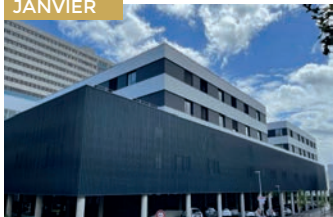
Ouverture du bâtiment Reine - Henri-Mondor
